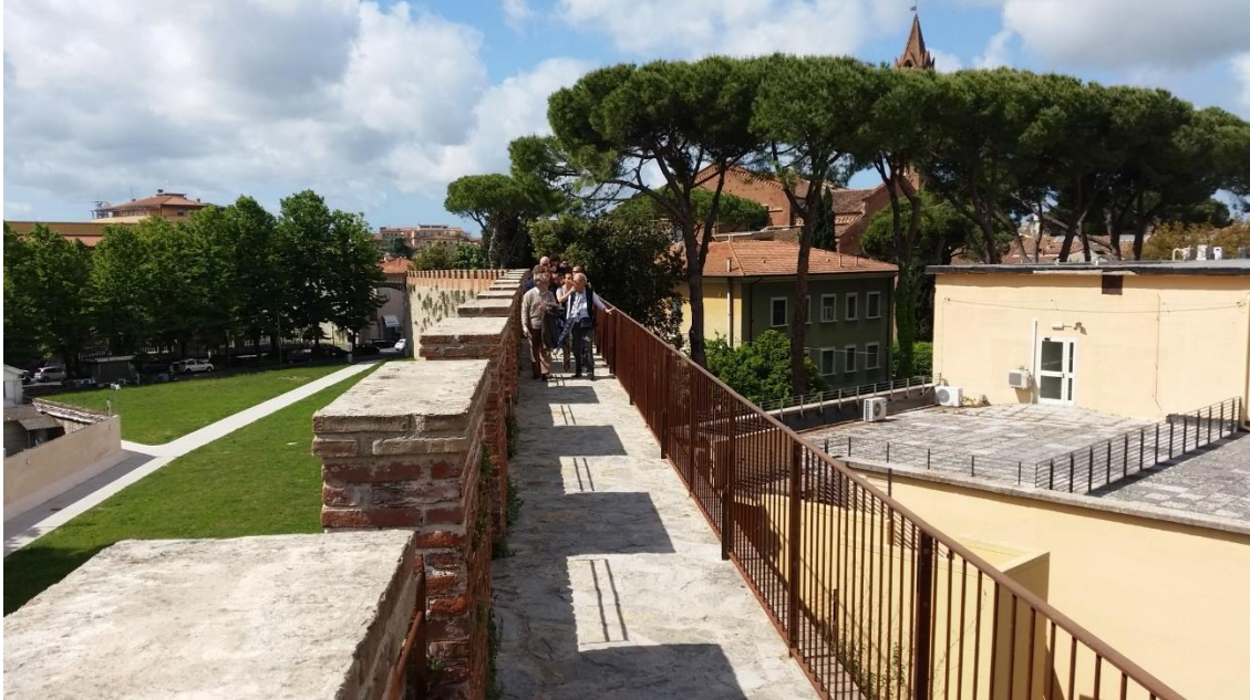
Camminata lungo le mura di Pisa all'altezza del complesso "Marzotto" e della chiesa di San Francesco
